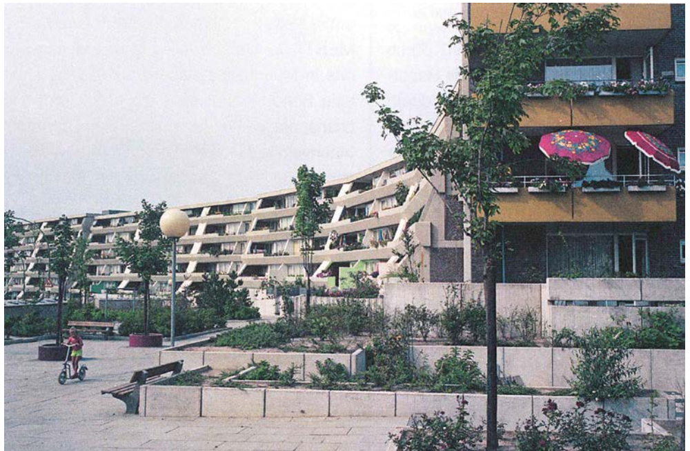
Terrassenhäuser in Mümmelmannsberg, 1975. (Bild: Lepik/ Strobl (2019): Die Neue Heimat)
