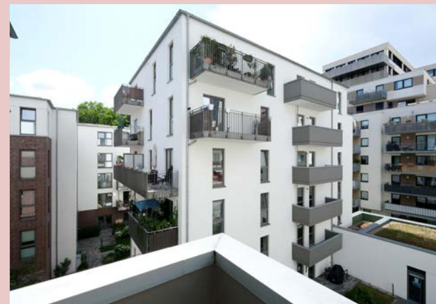
Hartwig-Hesse-Quartier in Hamburg-St. Georg: Modernes Wohnen für Jung und Alt (Bild: Michael Zapf, Hamburger Bündnis für Wohnstifte)
